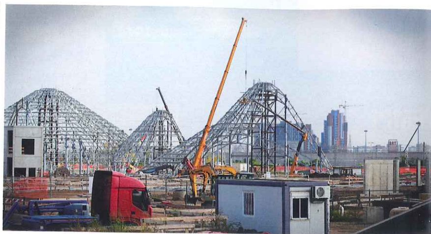
DUE IMMAGINI DEL CANTIERE DELL'AREA ESPOSITIVA, CHE SARÀ INAUGURATA IL PRIMO MAGGIO
